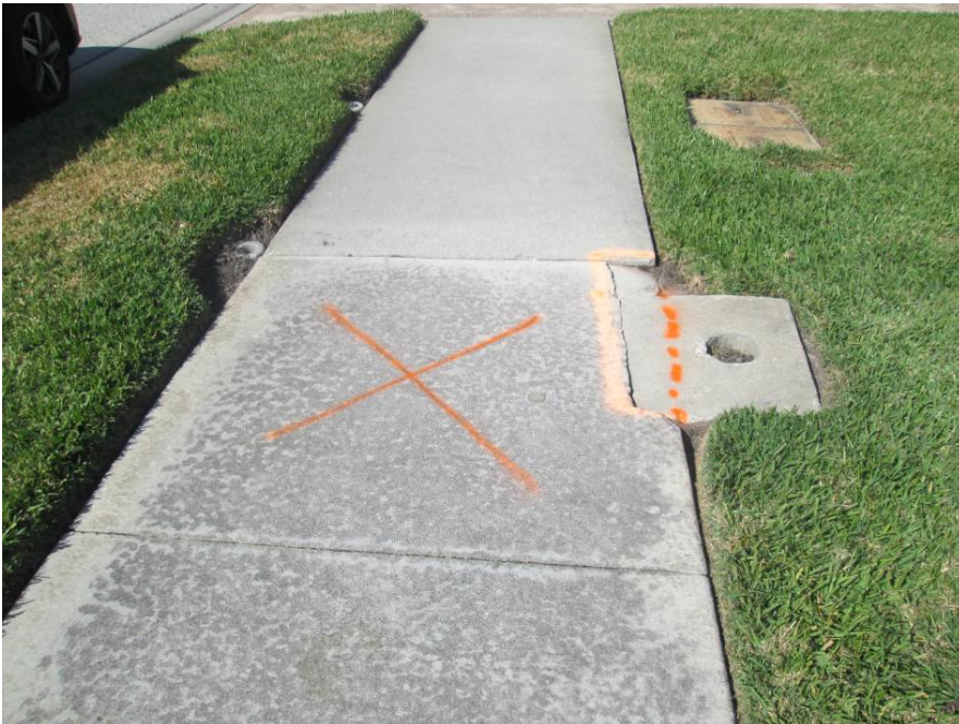
Remove sidewalk slab, cut valve pad, pour new sidewalk on Montelluna
